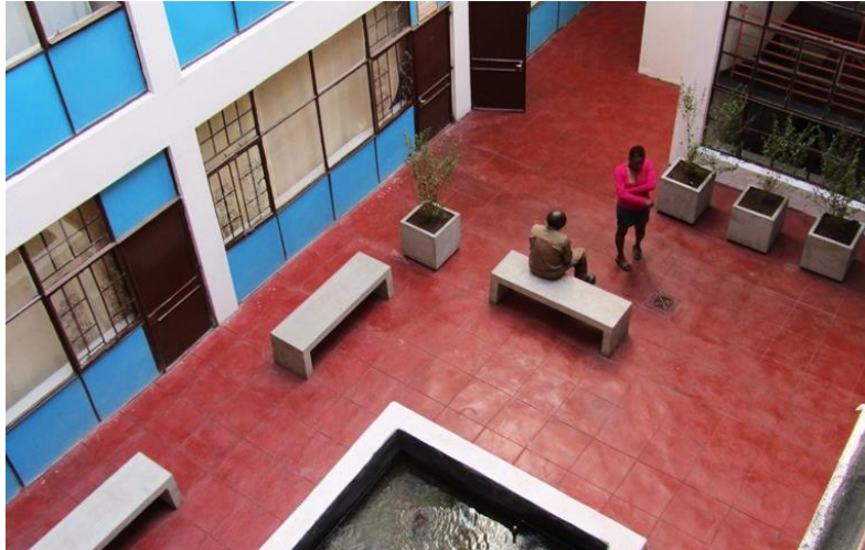
Cooke & Stewart, Aiton Court, Joanesburgo África do Sul, 1936-1937. Mayat Hart Architects, restauro, 2012-2014. Pátio central e fonte de água vistos de cima. © Mayat Hart Architects, 2014.
