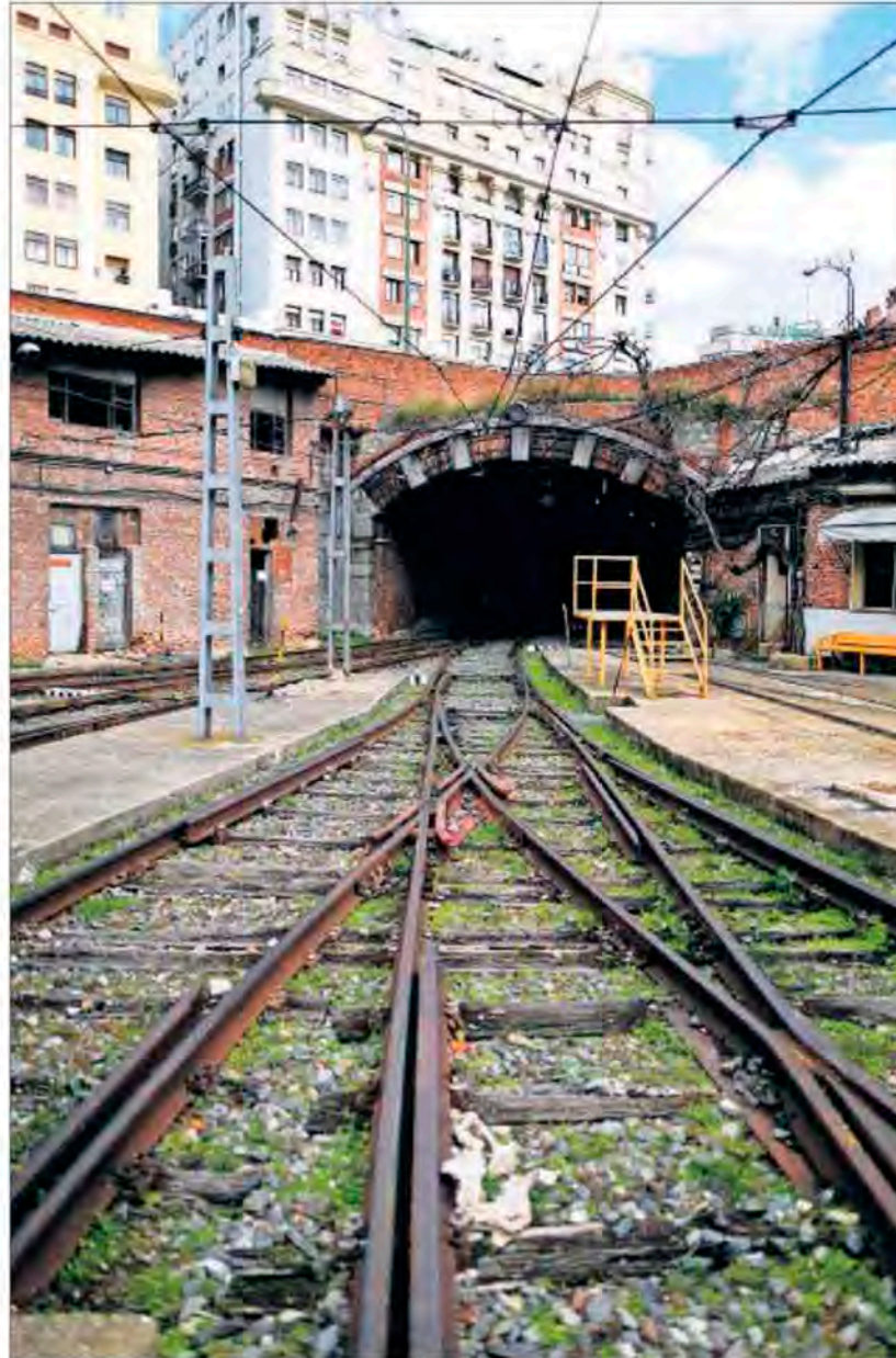
Vías del metro de las cocheras proyectadas por Antonio Palacios. / SAMUEL SÁNCHEZ
