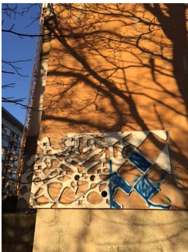
Estudo na fachada do edifício de escritórios Santo António © João Luís Marques, Dezembro 2017
