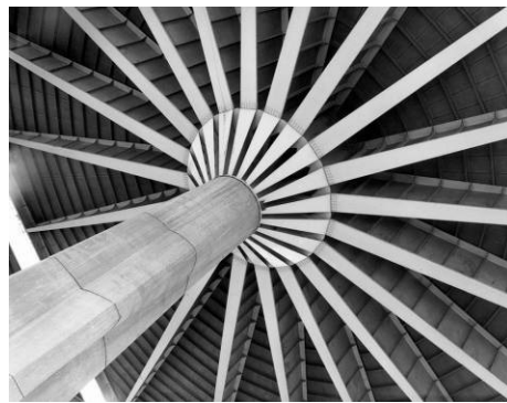
Fig. 12: Pier Luigi Nervi, with Antonio Nervi and Gino Covre – Palazzo del Lavoro, Turin, 1959-61
